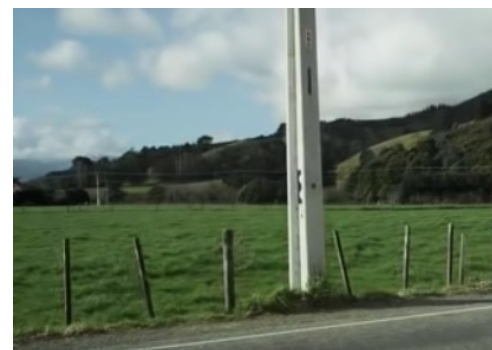
Poste junto à estrada
